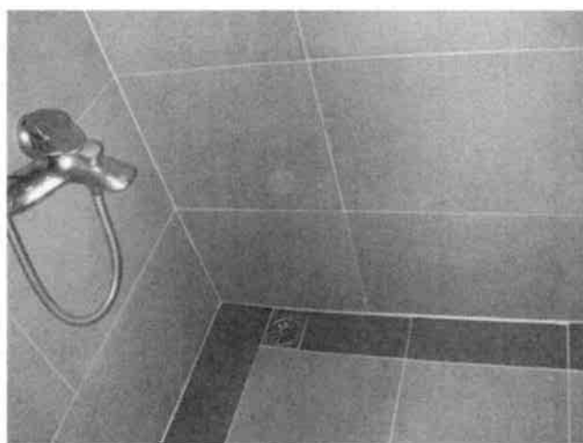
圖 18 採用大型磁磚的地坪置於牆邊的平頭落水頭
