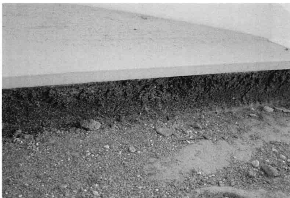
圖 26 採用大理石施工法的拋光石英磚地坪
